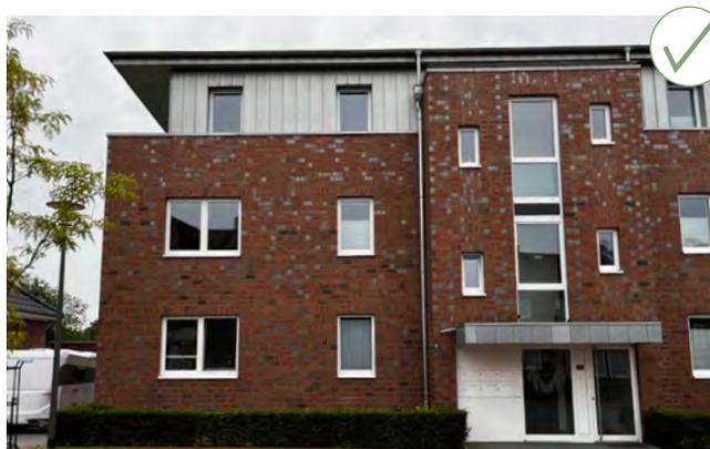
Abweichende Fassadenverkleidung in max. 30 % der umlaufenden Fassadenfläche (Zink)
