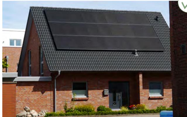
Gleiche Neigung wie das Dach, flache Anbringung (max. 0,2 m) und mind. 1,0 m Abstand zum Ortgang
